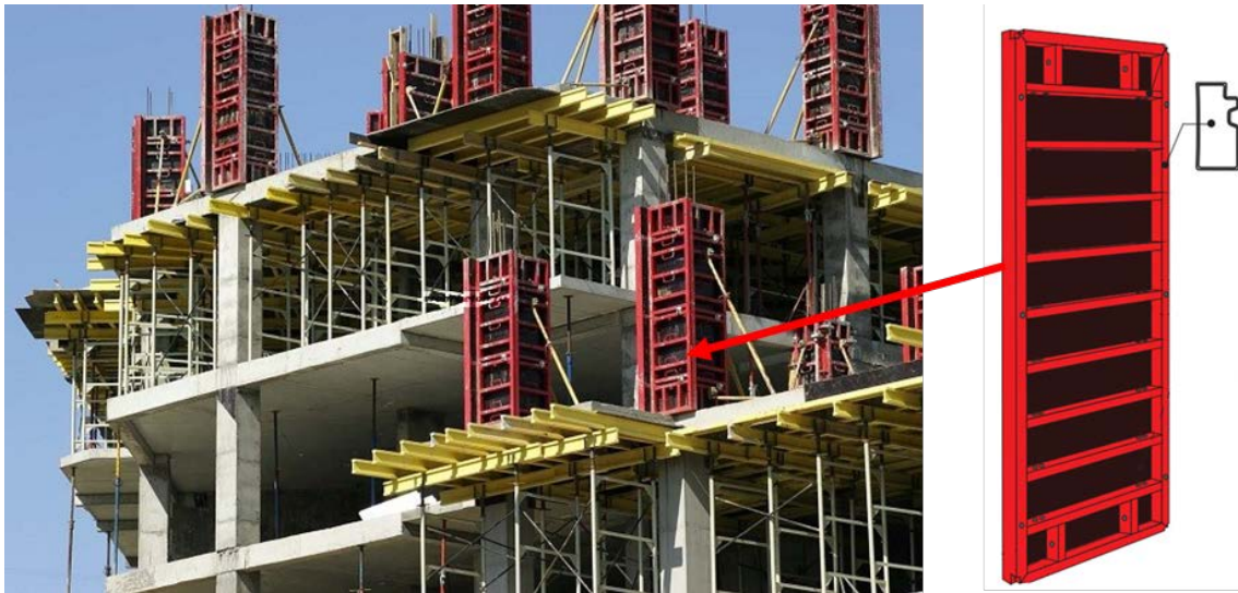
Рис. 1. Каркасные щиты рамочной опалубки при монолитном домостроении
