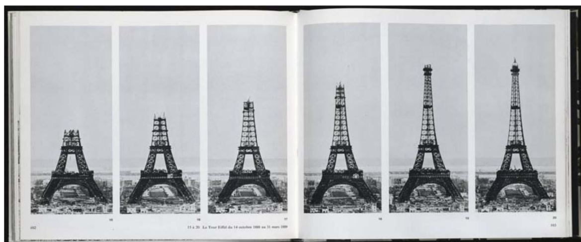
Рис. 2. Этапы строительства Эйфелевой башни
